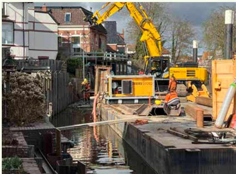
Vervangen kades van het Winsumerdiep
